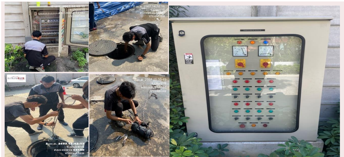
รูปที่ 2.4.2.2-3 ตู้ควบคุมระบบบำบัดน้ำเสีย
